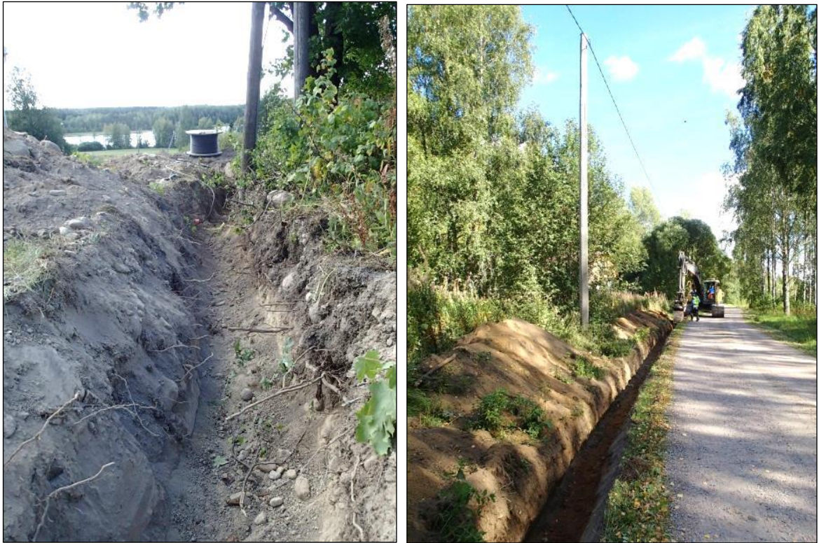
Vasemmalla kaivannon länsiosaa ja oikealla itäosaa.
