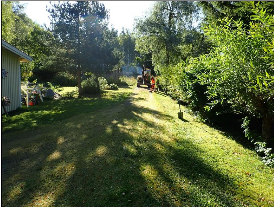
Kaivanto 1 ennen sen kaivamista. Kaivaminen alkoi lapion kohdalta. Itäkaakkoon
