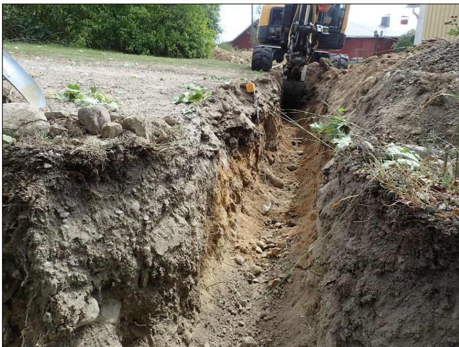
Mannamäentien poikki kaivettu kaapelioja. Kaakkoon.
