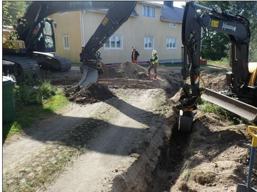
Kuvan taustalla kaivetaan kaivantoa 4 Mannanmäentien varteen. Kuvan etualalla kaivanto 1 talolle tulevan pihatien kohdalla. Kaakkoon.
