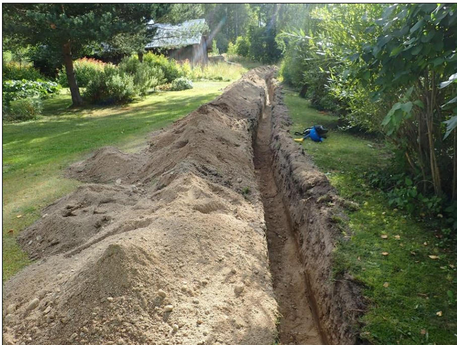
Kaivanto 1:n valmis se-pääty. Itäkaakkoon.
